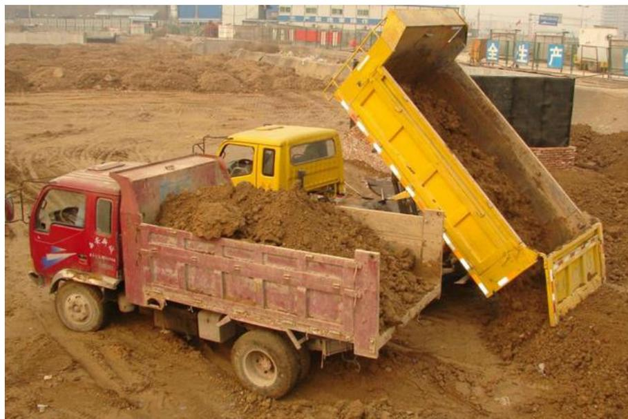
图 5.1-12 土方回填示意图
